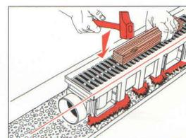
Udarati lagano čekićem kako bi kanali lepo prionuli uz betonsku podlogu.
