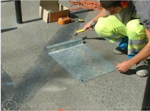
1. Postaviti šablon od lima ili sličnog materijala na dio poda gdje želimo ugraditi linije/čepove
